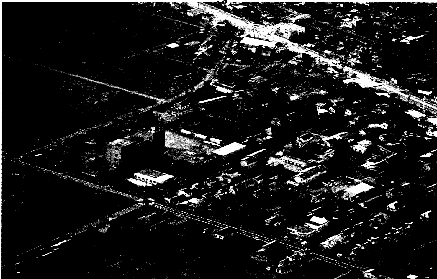
左の茶色の建物が双葉町役場。この一角が特定復興再生拠点に組み入れられている。2017年12月20日
