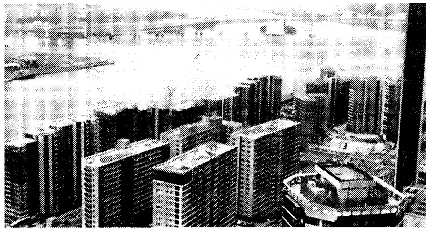
選手村建設工事の現況 (8月24日 近隣マンション屋上より)
