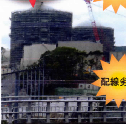
工事中の老朽原発・高浜1号機、2号機
