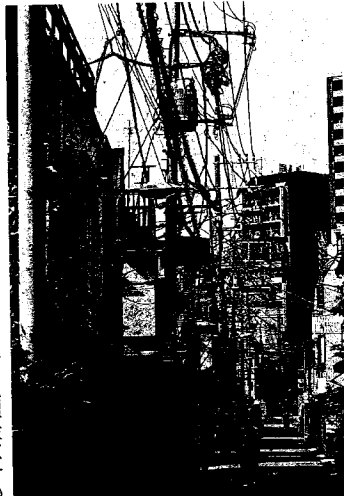
張り巡らされた電線。託送料金で維持されている=東京都品川区で
