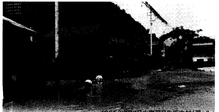
1965年7月3日水害翌日の坂本村(現、八代市坂本町)。荒瀬ダム建設前は家の2階まで水が来ることはなかったが、あつという間に電線の高さまで水が来て、臭い堆積物が溜まるようになった。(提供/つる様子)
